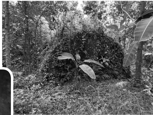
Gambar 4. Bagian Belakang Bangunan Sudah Setengah Tertutup Tanah Sumber: Widnyana, 2021
